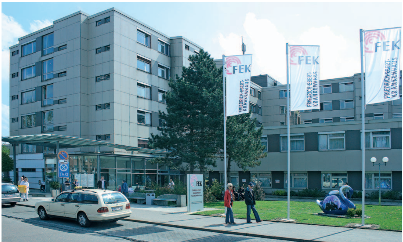
Das Friedrich-Ebert-Krankenhaus in Neumünster, ein mittelständiges Unternehmen mit 1.400 Mitarbeitern
